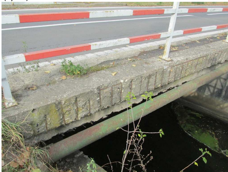
17) NK – pohled zprava (výtok) / detail degradace betonu říms s obnaženou korodující výztuží
